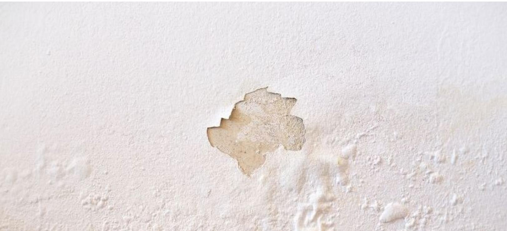
Generalmente se produce por el uso de la vivienda y prácticas de ventilación poco adecuadas. La ventilación favorece además la eliminación de olores desagradables (encierro) y facilita la buena conservación de pintura, pisos, etc. Por esta razón en su vivienda encontrara ventanas con perfiles anti condensación o celosías, ubicados en la parte superior de las ventanas o puertas con el fin de ventilar los espacios.
