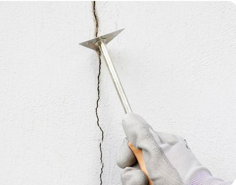
como mínimo un año para verificar que no se producirán más fisuras, para luego proceder al resane con masillas elásticas y al repintado de los muros o techos.
