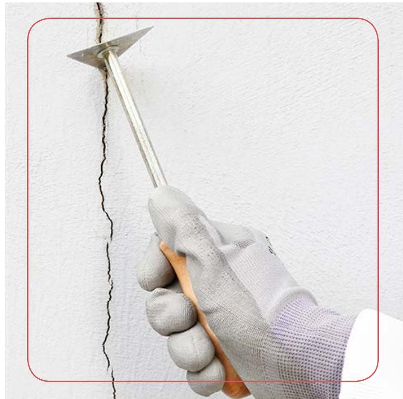
Esto afecta principalmente a: uniones entre planchas y elementos de distintos materiales, que tienen diferente grado y velocidad de dilatación o contracción tales como: prefabricados, cielos, uniones de elementos de madera como marcos de puerta, etc. Para solucionar esto, es que en ocasiones se proyectan dilataciones que inducen estas fisuras.
